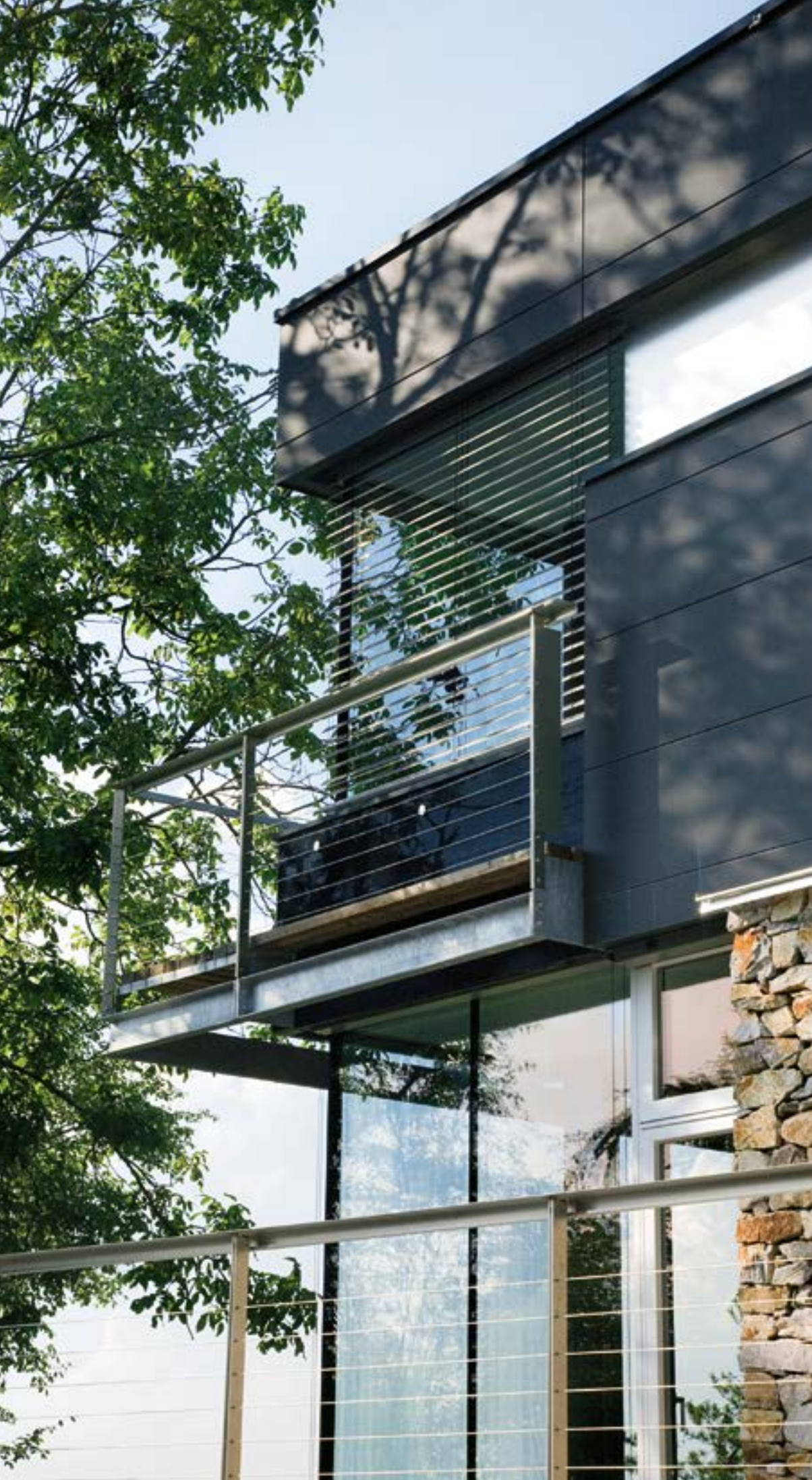
Gläser mit Statiklisene: Außen Alu schwarz eloxiert innen nach Wahl in Holz in der Fensterfarbe oder als schlankes Aluminiumprofil nach RAL
